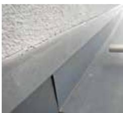
Abb. 1: Seitlicher Wandanschluss mit Z-Putz-Leiste.
