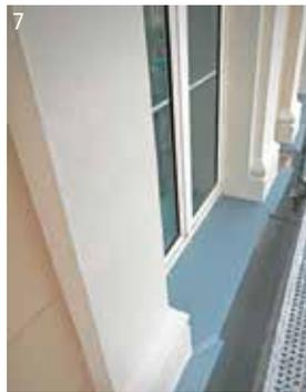
dass schon bei Fensterbanklängen von etwas mehr als einem Meter und Fertigstellung der Putzfassade an heißen Sommertagen (größte Länge der Fensterbank) die auf die Rückseite der Putzfläche einwirkenden Kräfte im Winter durch die Bauteilverkürzung so hoch sein können, dass selbst bei zehn Millimeter Aufkantung Risse im Laibungsbereich möglich sind (Abb. 5). Die einzige Möglichkeit, Risse 100-prozentig zu vermeiden, sind C-Vorköpfe, die schon seit Jahrzehnten erfolgreich zur Anwendung kommen.
