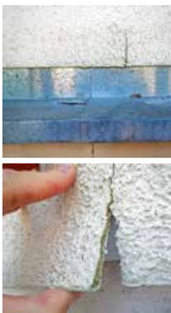
Abb. 2+3: Übergang WDVS mit Kunststoffprofil, Rissbildung durch mangelnde Dehnungsaufnahme.
