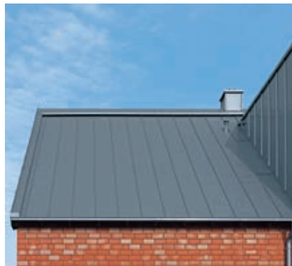
Stehfalzdeckung mit schmaler Giebelabdeckung und Lüfterfirst
