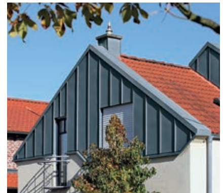
Giebelbekleidung mit Abdeckung
