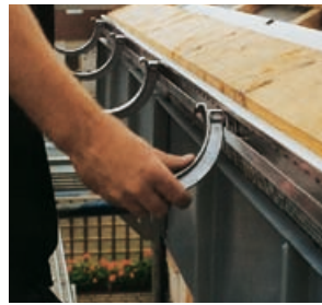
Rinnendrehhalter werden im Bereich der Sparren in die Montageschiene eingesetzt
