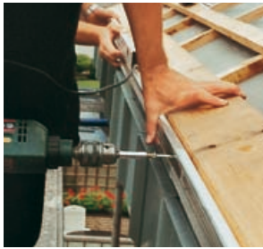
Montage der RHEINZINK-Rinnenschiene unterhalb der Trauflinie
