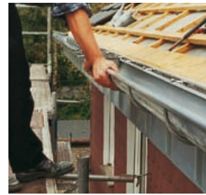
Durch Einklicken wird die RHEINZINK-Dachrinne sicher und dauerhaft fixiert
