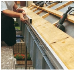
Überprüfung der Unterkonstruktion auf Fluchtgenauigkeit und Lot
