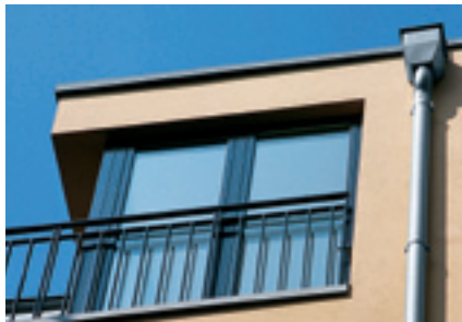
Geschützte Fassade durch RHEINZINK-Dachrandabdeckung
