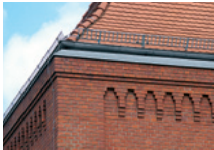
Gebäudeknickpunkt mit RHEINZINK-Tauf- und Gesimsprofilen
