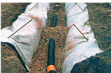
Variante einer Rohrrigole
