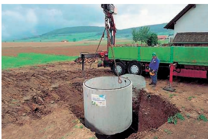
Montage eines Versickerungsschachtes
