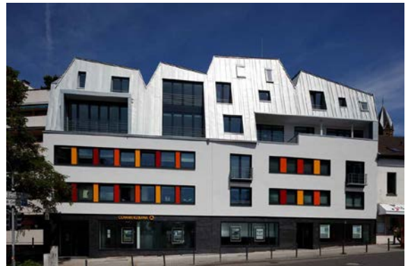
Dachlinie als Blickfang: Die massiven Untergeschosse aus den 1950er Jahren erhielten eine Aufstockung in Holzleichtbauweise mit markant geformtem Titanzinkdach. Foto: RHEINZINK
